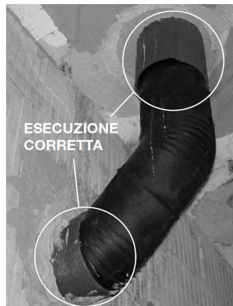
Figura 7-7: Passaggio delle tubazioni tra piani sovrapposti
