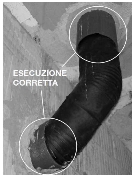
Figura 7-7: Passaggio delle tubazioni tra piani sovrapposti
