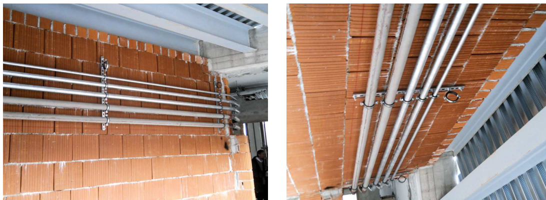
Figura 7-3: Fissaggio tubazioni con sistemi antivibranti
