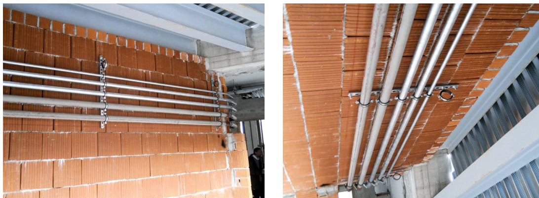
Figura 7-3: Fissaggio tubazioni con sistemi antivibranti
