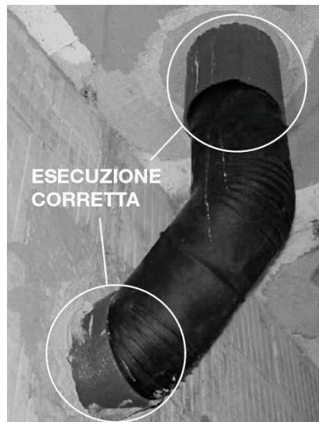
Figura 7-7: Passaggio delle tubazioni tra piani sovrapposti
