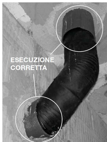
Figura 7-7: Passaggio delle tubazioni tra piani sovrapposti
