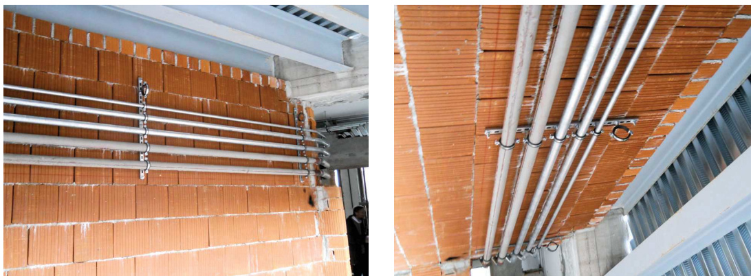
Figura 7-3: Fissaggio tubazioni con sistemi antivibranti
