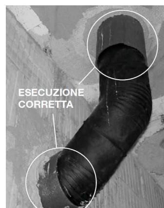
Figura 6-7: Passaggio dei canali e delle tubazioni attraverso piani sovrapposti
